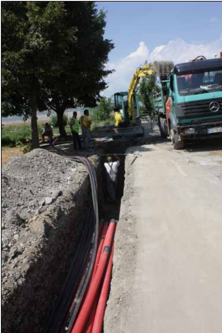
Sl.3: Pogled na izkop za Jašek 4 (foto: T. Mlakar).
